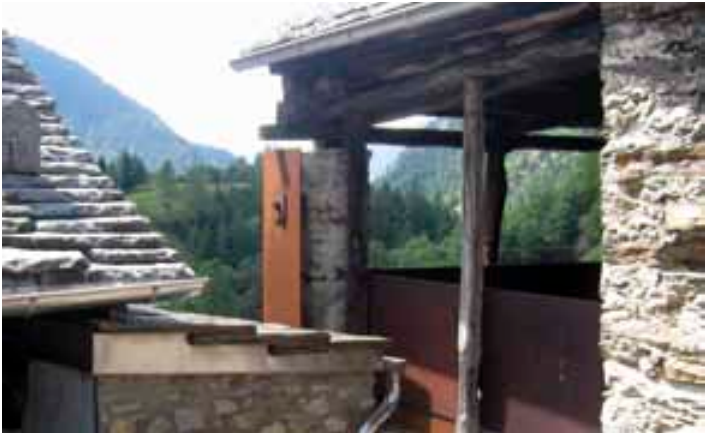
Fusio – detail ztužení původní konstrukce
