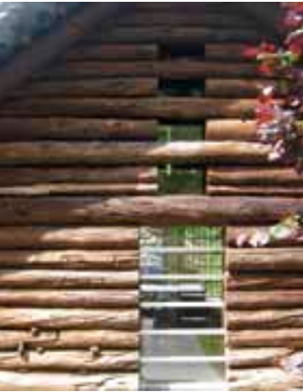
Fusio – nová okna v původní konstrukci
