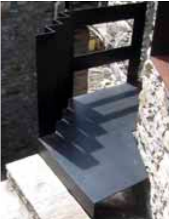
Fusio – dům Al Forn, detail schodiště
