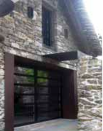
Fusio – rekonstrukce domu Rocca
